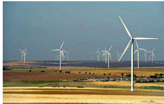
The 600-MW Fantanele-Cogealac wind farm in Romania. Source: ČEZ, a. s. (www.cez.cz).
